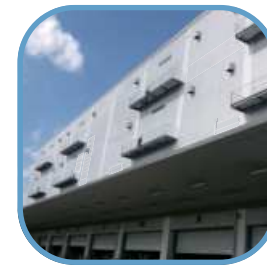
相模原ロジスティクスセンター
